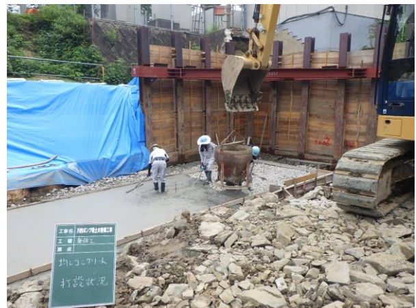
☆均しコンクリート打設状況☆
