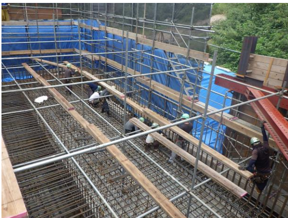
☆鉄筋組立状況☆
