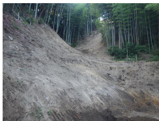
☆法面掘削完了☆
