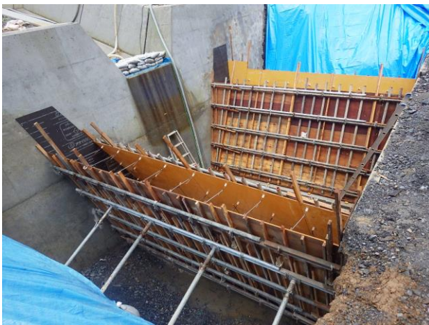
☆護岸工型枠組立完了☆
