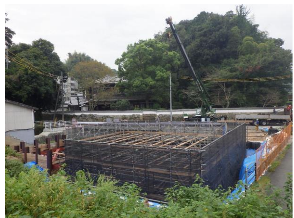
☆工事現場全景☆
