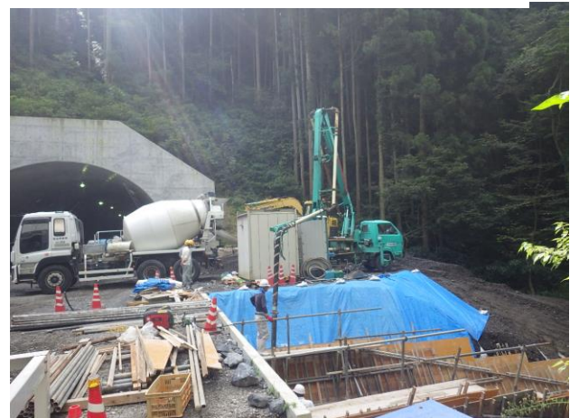
☆護岸工コンクリート打設業況☆
