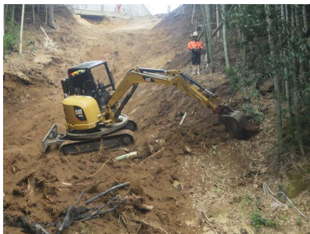
☆遠隔操作重機による法面掘削☆
