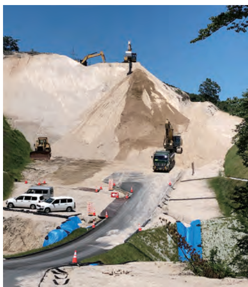
山を掘削して道路を新設する工事
